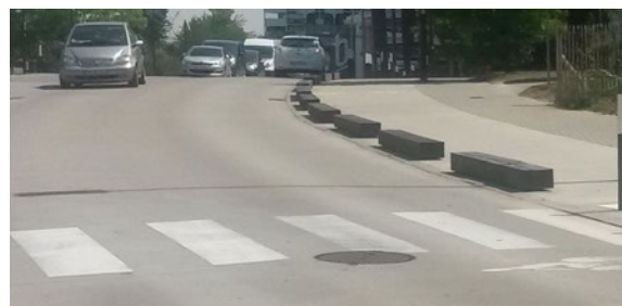
Des madriers au sol et des potelets ont été utilisés en alternance pour protéger les cheminements piétons du stationnement. La disposition des madriers le long du cheminement ne gêne pas le déplacement des piétons, même s'ils restent toutefois des obstacles pour des personnes qui dévièrent de leur trajectoire
