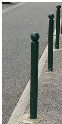
Dans cet environnement homogène, les potelets ont été choisis pour être contrastés par rapport au contexte. Il n'a pas été jugé nécessaire de rajouter une bande contrastée en partie haute
