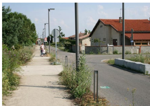
Les deux photos ci-dessus illustrent des potelets/bornes hors cheminement, qui ne sont pas soumis aux obligations de taille minimale et de contraste visuel
