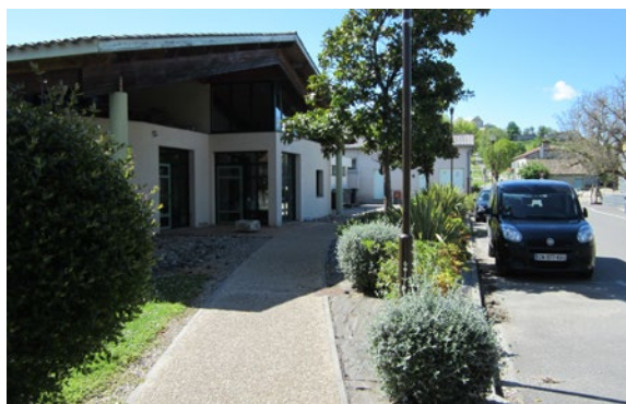
Un entretien régulier est à prévoir pour que la végétation ne déborde pas sur le cheminement piétonnier ou sur la chaussée
