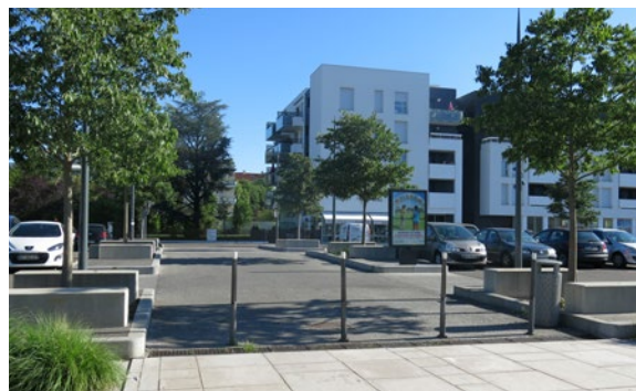
Corps du potelet peu contrasté par rapport à l'environnement. Ajout d'un contraste en partie sommitale avec une peinture blanche
