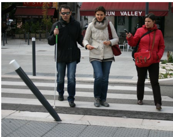
Potelet dégradé créant un obstacle dangereux au niveau d'une traversée
