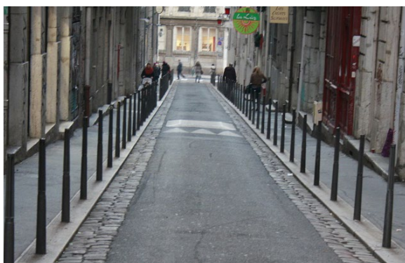
Anti-stationnement : potelets implantés en bord de trottoirs pour bloquer physiquement la possibilité de stationner sur le trottoir
