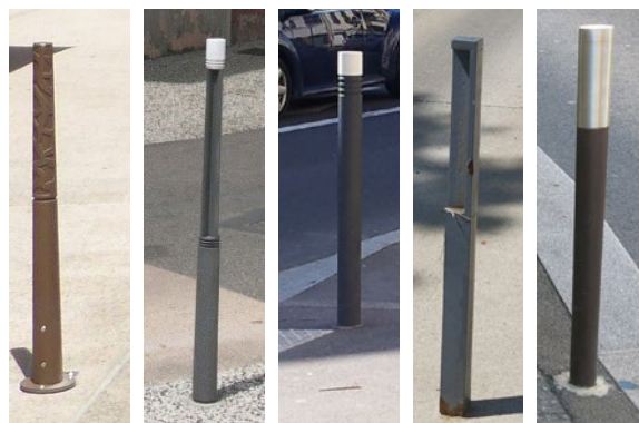
Exemples de potelets a priori conformes aux exigences de contraste visuel (soit entre le potelet et son environnement, soit entre les deux parties du potelet) et de dimensions
