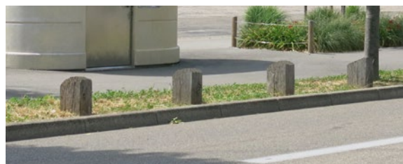
Potelet dans le cheminement piéton, respectant l'abaque de détection et la demande de contraste
